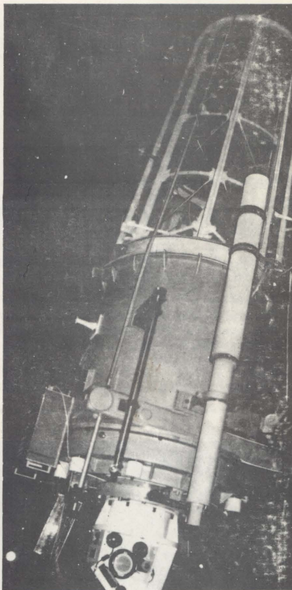
Stockholms observatoriums nyaste instrument — ett Schmidt-teleskop — används bland annat för fotografiskt bestämmande av stjärntemperaturer och för att spåra nybildade stjärnor. Se sidan 6! Foto: IGF, Stockholm.
